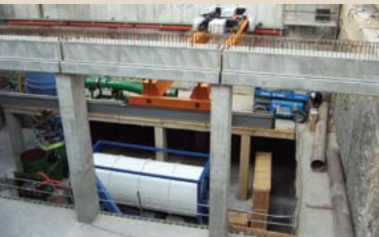
Central RPRSU l'Illa Robadors (Raval) en obres Central RNRSU de la Illa Robadors (Raval) en obras
