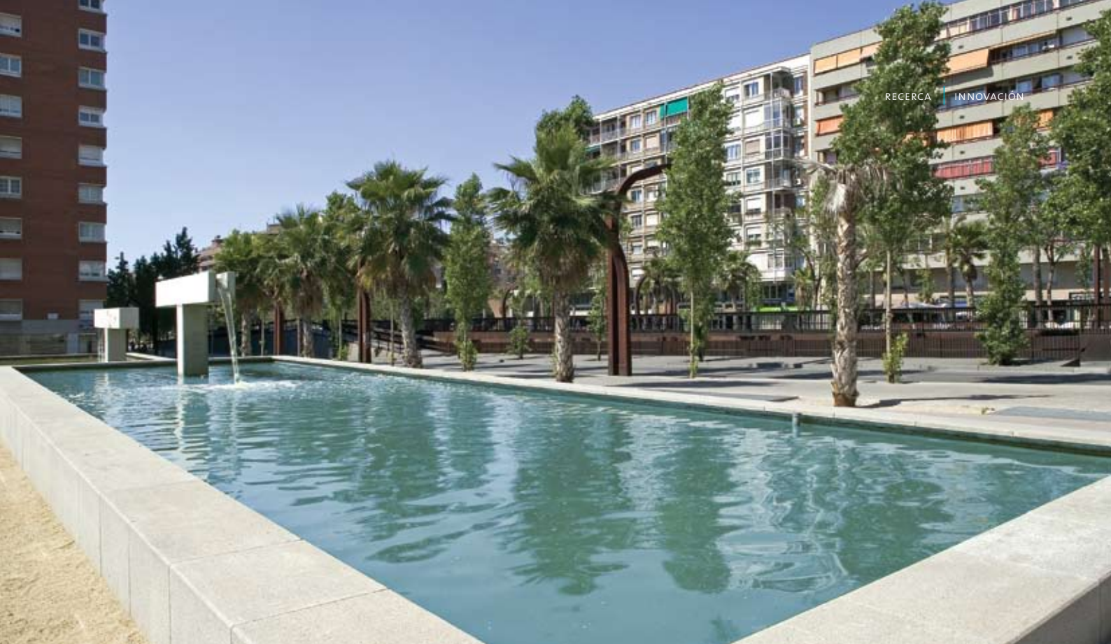
Plaça exterior del Dipòsit de retenció d'aigües pluvials de Doctors Dolsa | Plaza exterior del Depósito de retención de aguas pluviales de Doctors Dolsa
