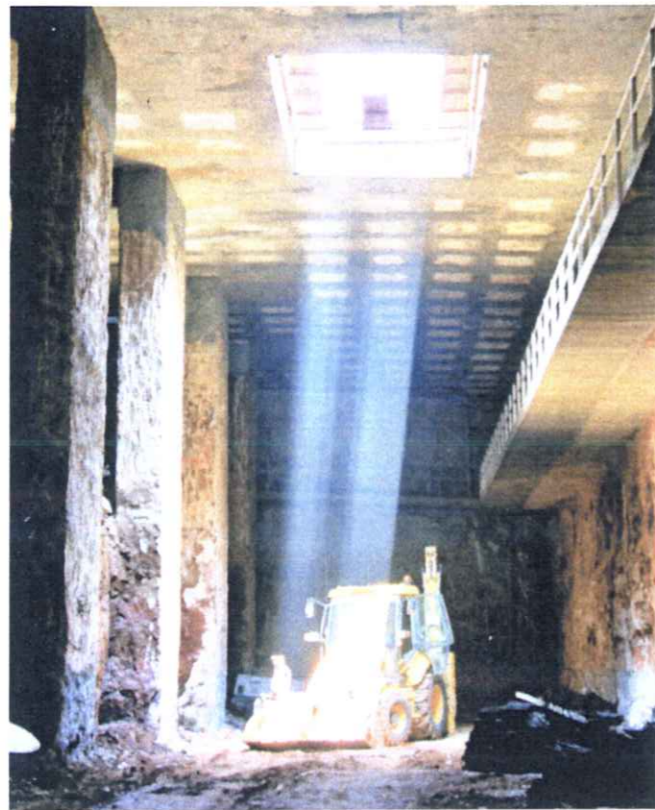
Arriba, depósito de Doctors Dolsa en construcción por el método de construcción inversa. Debajo, vista del interior del depósito de 'Joan Miró'
