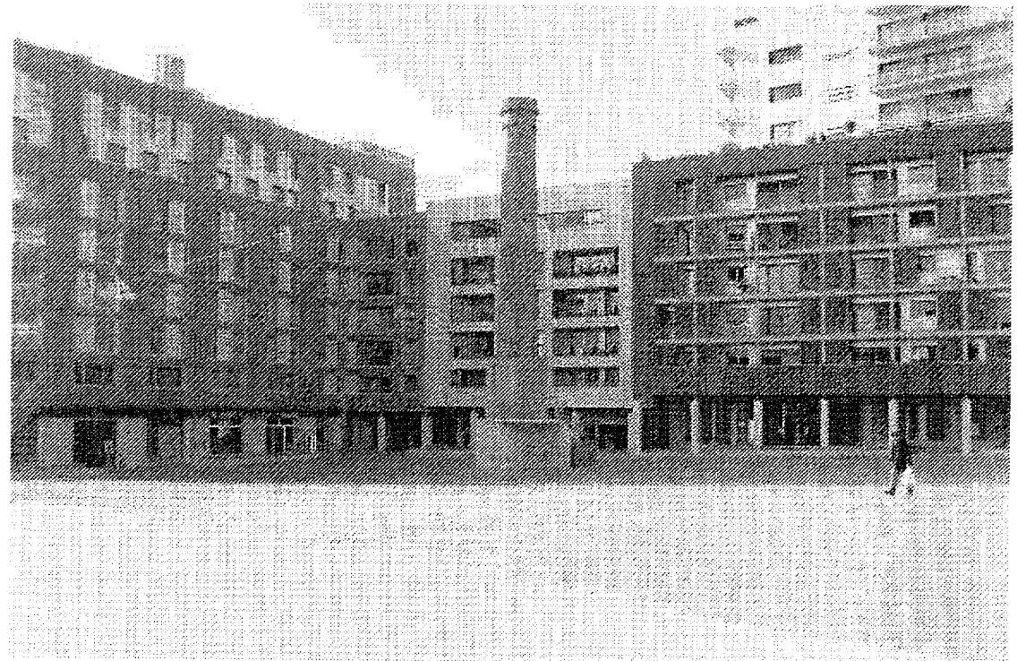
En la promoció de pisos del Vapor Gran ja hi ha la instal·lació feta, però encara no ha entrat en funcionament. / J.A.
