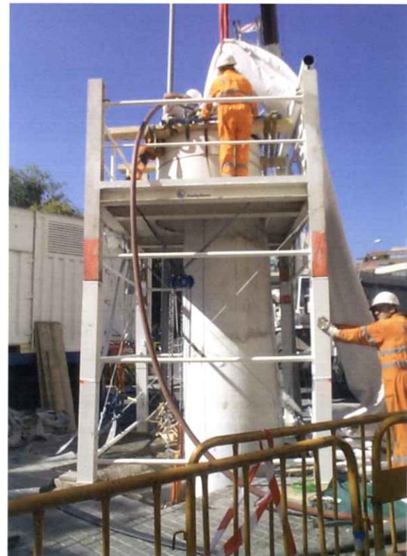
Obra de rehabilitación: renovación mediante manga reversible
