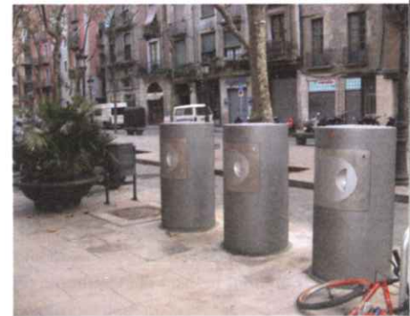
Buzones de recogida neumática de residuos sólidos
